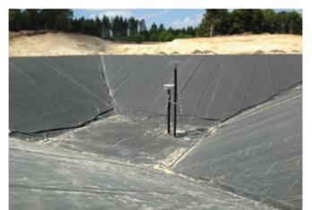
Bau des Erdbeckens - Wärmespeichers in Dronninglund (DK, 60'000 m<sup>3</sup>)
